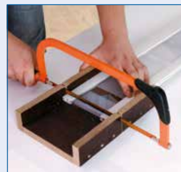
Zuschneiden der Profile auf die benötigte Länge.
