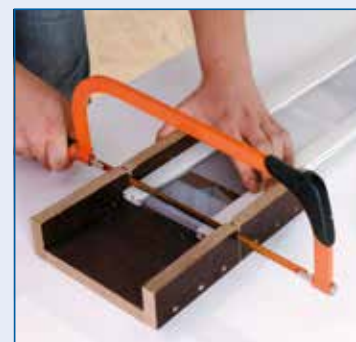
Zuschneiden der Profile auf die benötigte Länge.
