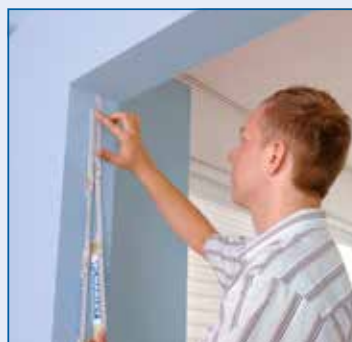
Ausmessen der Türöffnung (Breite und Höhe).
