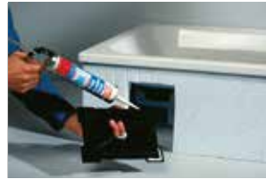
Fliesenrahmen umlaufend mit Silikon versehen.
