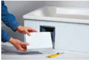
Revisionsöffnung aus dem Hartschaumblock ausschneiden.
