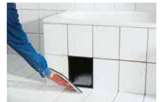
Fliesenrasterplatte mit aufgeklebten Fliesen einsetzen und verfugen.
