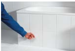
Durch Abklopfen der Fliesen lässt sich die Revisionsöffnung leicht wiederfinden.
