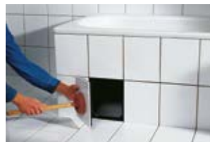
Die umlaufende Fuge entfernen und die Fliesen Trägerplatte mit einem Sauger aus dem Rahmen lösen.
