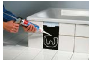
Die Fliesen mit Silikon auf die Trägerplatte aufkleben. Die überstehende Fliesenfläche nicht verkleben.
