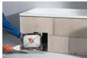
Den Fliesenrahmen umlaufend mit dauerelastischem Fliesenkleber versehen und in die Revisionsöffnung einkleben. Aushärtezeit beachten.
