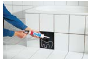
Die Fliesen mit Silikon auf die Trägerplatte aufkleben.
