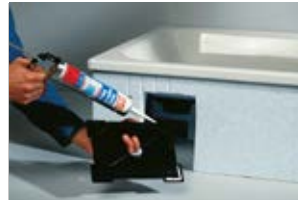
Fliesenrahmen umlaufend mit Silikon versehen.
