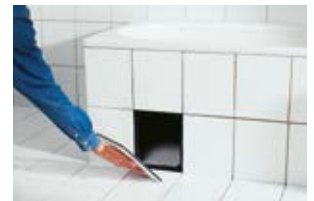
Fliesenträgerplatte mit aufgeklebten Fliesen einsetzen und verfugen.
