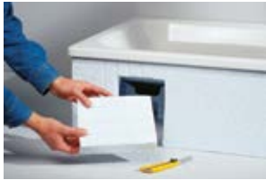
Revisionsöffnung aus dem Hartschaumblock ausschneiden.
