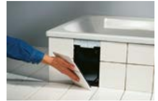
Die Trägerplatte in den Fliesenrahmen einsetzen und die gesamte Fläche wie üblich verfugen.
