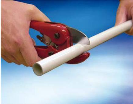
**1** Das Rohr mit einer Rohrschere rechtwinklig ablängen.
