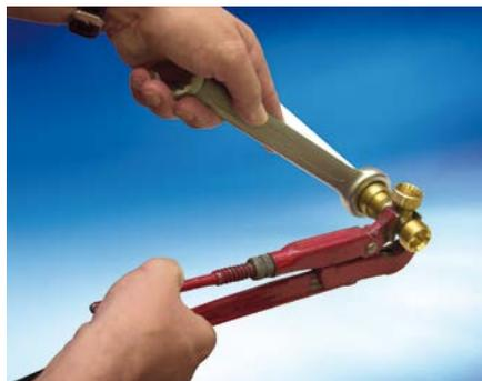
**5** Kräftiges Anziehen der Überwurfmutter mit Schlüssel und Rohr- zange nach handwerklicher Art.
