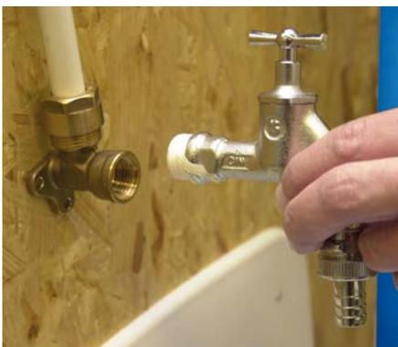
**1** Wandwinkel für Aufputz- installation. Die Anschlussverschraubung der Armatur ist mit Teflonband einzudichten.
