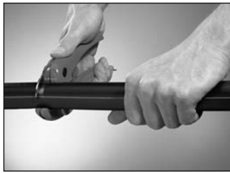
Rohr mit Schere für Kunststoffrohr durchschneiden.
